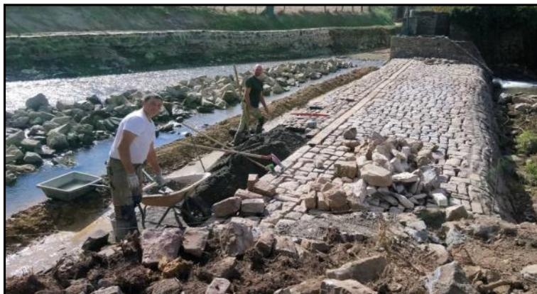
Avec le niveau d'eau abaissé, la commune refait les murs le long du « chemin des dames » sur 50 mètres. « Le déversoir ancien est arasé de 65 cm et le clapet est maintenu, mais à une cote plus basse. Et une rivière de contournement est aménagée rive droite, permettant le franchissement optimal des espèces piscicoles. Ce bras sera interdit à la pêche », précise le technicien.
