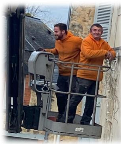
Installation des illuminations de Noël par les agents des services techniques municipaux.
