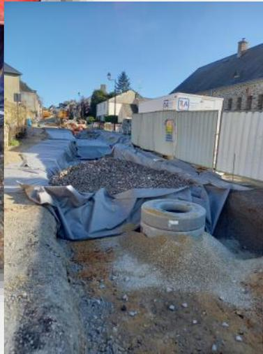
Un chantier emprunt des nouvelles technologies en matière d'environnement avec la création d'une chaussée réservoir qui permet de capturer l'eau de pluie en évitant les risques trop importants de ruissèlement et qui joue un rôle de régulateur thermique par évaporation en période de grande chaleur.
