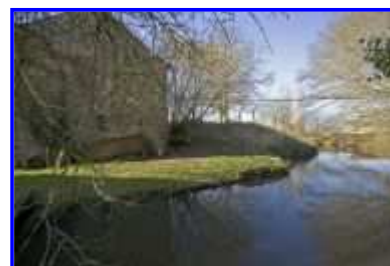
Vue partielle vers l'ouest.
