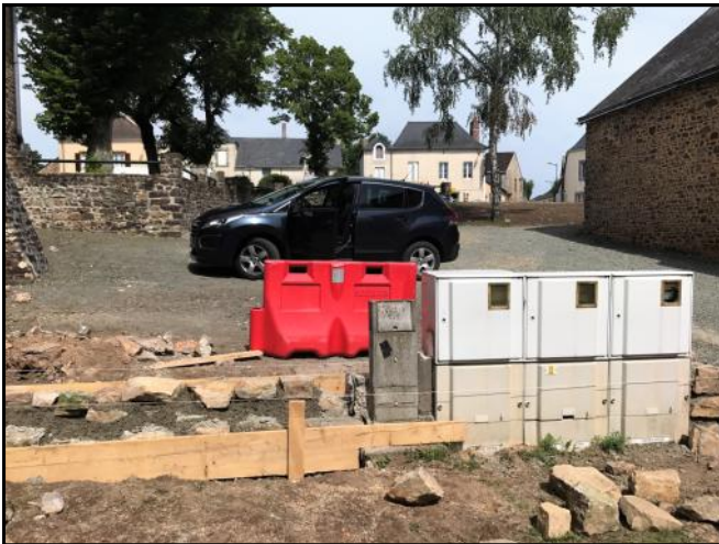
Travaux devant la mairie de Chammes avant aménagement du parking (Michel Delétang)
