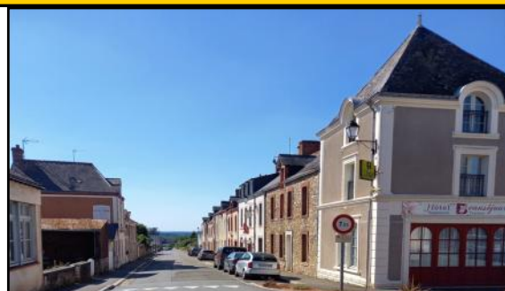
Le chantier partira de la rue de la Libération avec une intégration patrimoniale d'entrée vers la cité médiévale
