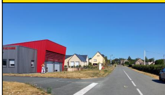
Le chantier se terminera à l'entrée de village au centre de secours
