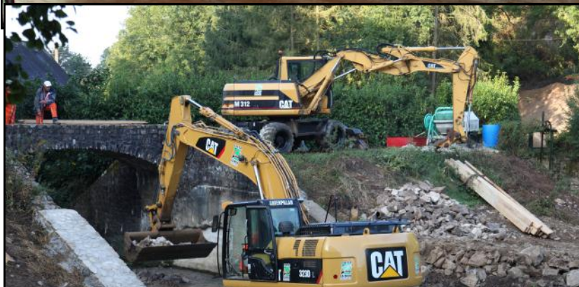
Travaux au Grand Moulin
